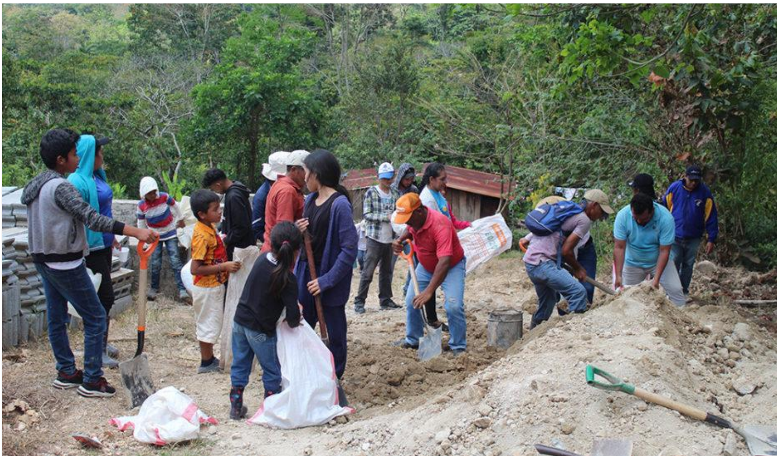
Les membres des coopératives nicaraguayennes participent à la construction des maisons. URBAMONDE SUISSE
