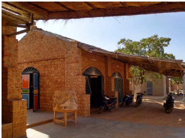
Salle de formation de Yaam Solidarité, support d'un chantier-formation
