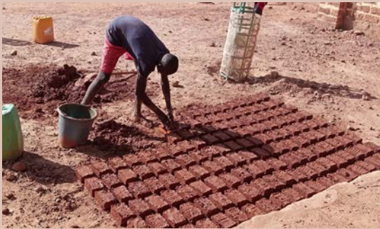
Production d'adobes (briques en terre crue) au Burkina Faso
