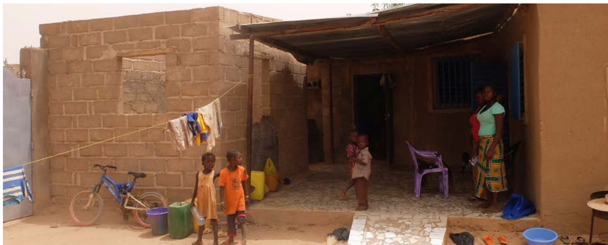
Logement réhabilité chez la famille Ilboudo à Boassa
