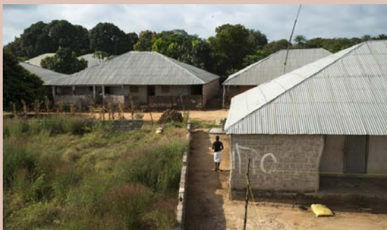
Aménagement et disposition des maisons dans le quartier de Djaraf à Canchungo
