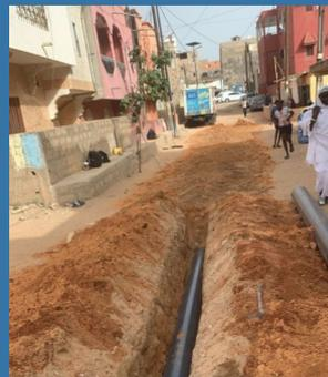
Réseau de drainage des eaux pluviales
